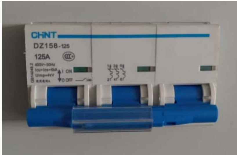
图 6-1 空气开关关闭状态
